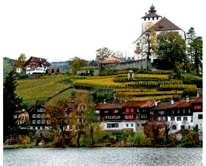
Die notwendigen Sanierungsarbeiten im 800 Jahre alten Schloss waren überraschend umfangreich. (Foto: ZVG)
