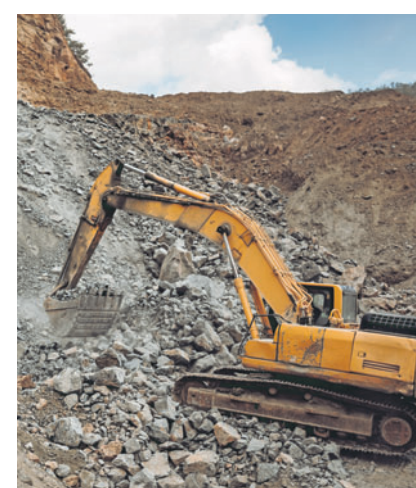
Nachhaltig und wirtschaftlich soll der Deponieraum genutzt werden. (Foto: SSI)
